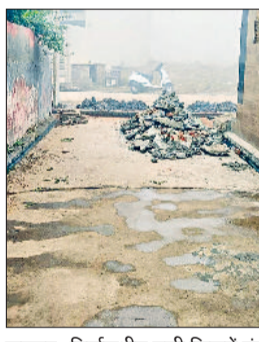
झज्जर। निर्माणधीन गली जिसमें ऊंचा किया जा रहा नाली का लेवल।
